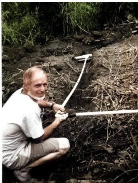
David Hosick verlegt Wasserrohre in alle Schulgebäude.
